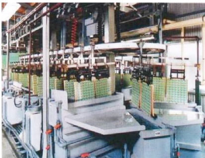
電解硬質金めっき自動1号機
